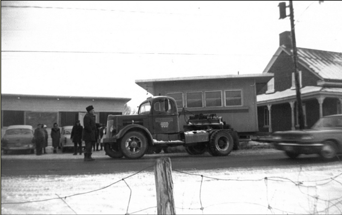
Déménagement du Petit restaurant le 27 décembre 1963 avec le nouveau à l'arrière
